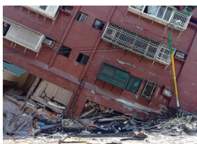
倒壊した花蓮県の高層ビル
